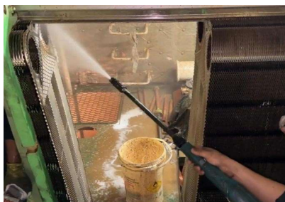
Gambar 3. Proses Pembersihan FWC
